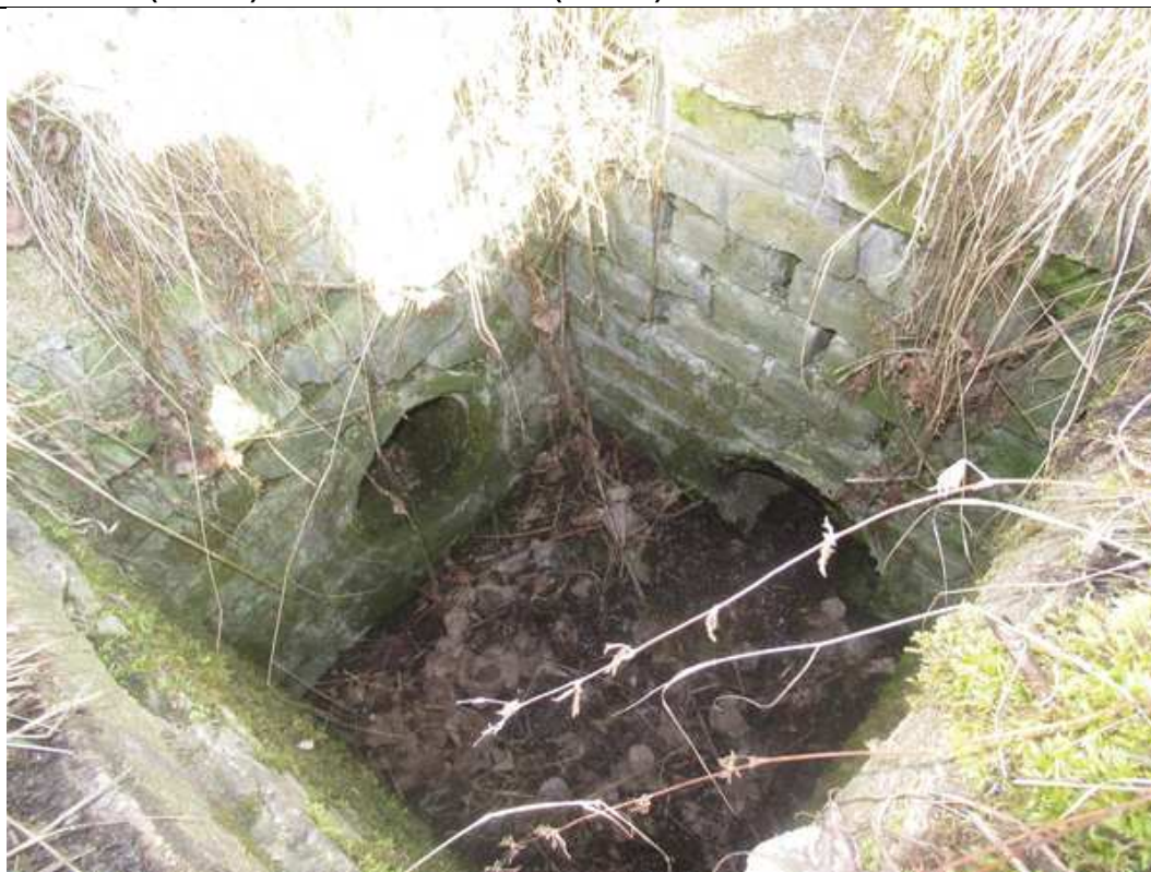
Obr. č. 5 - pohled do šachty Š3 na přítokovou (vlevo) a odtokovou (vpravo) betonovou rouru
